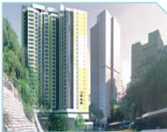
▲ Shek Pai Wan Road Project 石排灣道項目
