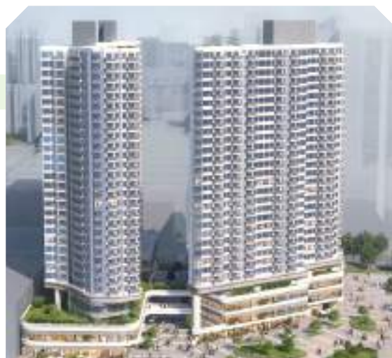
▲ Ma Tau Kok Link Site project 馬頭角連接用地項目
