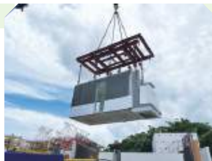
▲ Modular Integrated Construction method 「組裝合成」建築法
