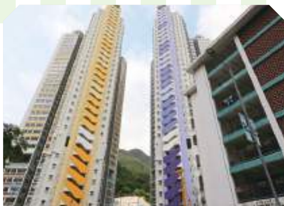
▲ Ming Wah Dai Ha Redevelopment Phase I 明華大廈重建第一期
