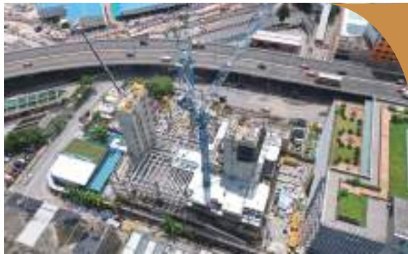
興建中的香港郵政大樓 The new Hongkong Post Building under construction
