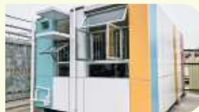
▲ Steel MiC modules for Jat Min Chuen's Chung Yuet Lau. 鋼製組件的「組裝合成」建築法組件將於乙明邨松悅樓進行安裝。
